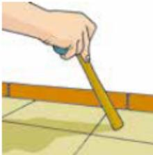
**6.2. Cerâmico: com juntas inferiores a 5mm. Antes da aplicação da massa de preparação ou autonivelante é necessário o uso de um primer promotor de aderência ou uma demão de adesivo de duplo contato.**
